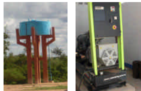
Chaque poste de contrôle est équipé d'un forage, d'un château d'eau et d'un groupe électrogène
